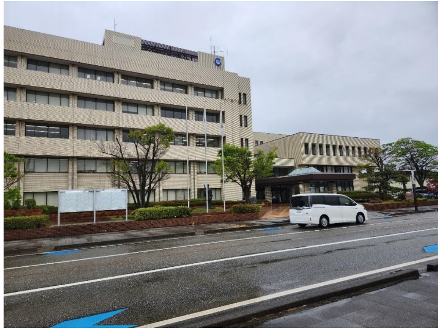
七尾市 本庁舎
