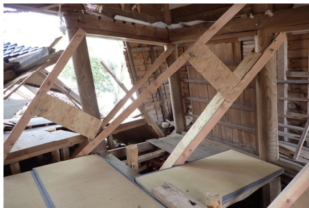
支保工を施し、作業者の安全を確保
