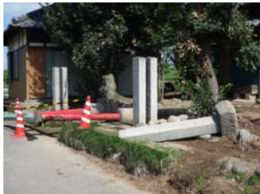
白髭神社の被害状況（熊谷市）
