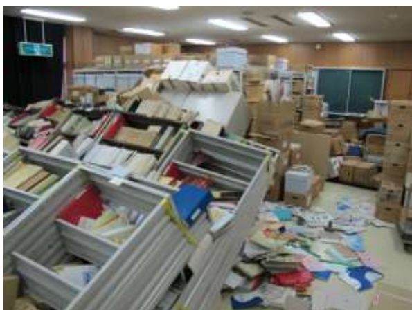
書架の倒壊（幸手市 平成23年）
