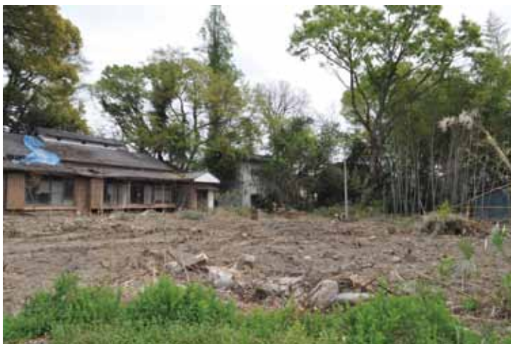
5-2 主屋の取り壊し風景
