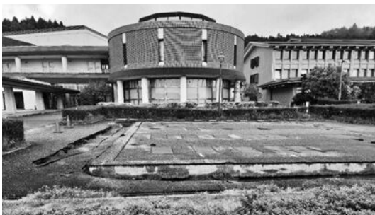
七尾市中島庁舎
